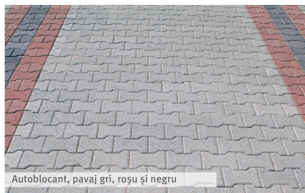
Autoblocant, pavaj gri
